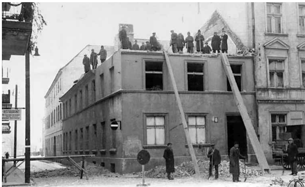
Burzenie dawnej kamienicy Chodyńskich (dom nr 142) przy ulicy Piekarskiej/Sukienniczej
