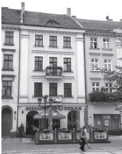
Kamienica nr 14 – elewacji frontowa
