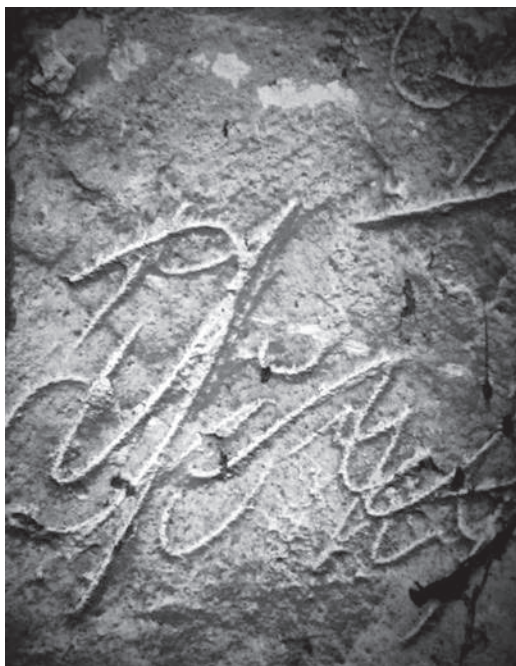
Inicjały murarzy na ścianie strychu
