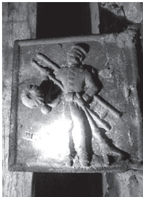
Drzwiczki – wylot do komina na strychu
